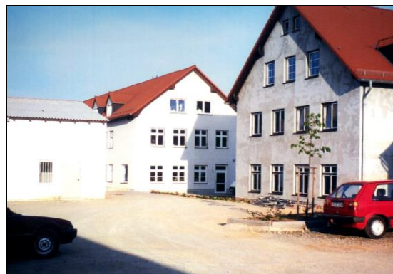
Der Verwaltungsbau des Förderkreises „JUL“ e. V. links und der Ausbildungsbereich des ERGaB rechts im Bild
