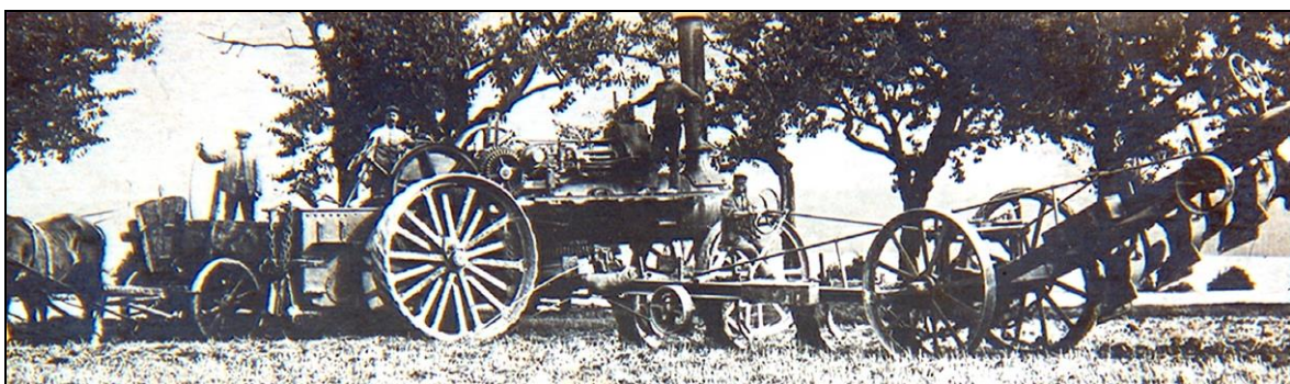
Eine der Zugmaschinen mit dem Kippflug (rechts), dem eigentlichen Pfluggerät
