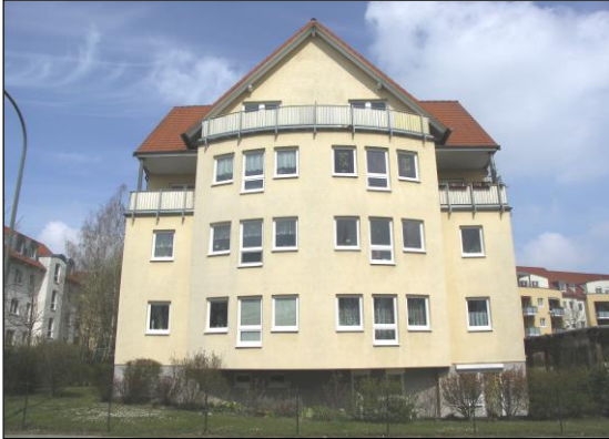
Die Nordbebauung der Bruno-Apitz-Straße im östlichen Teil
