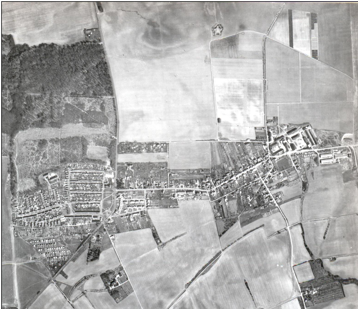
Eine Luftbildaufnahme vom April 1982
