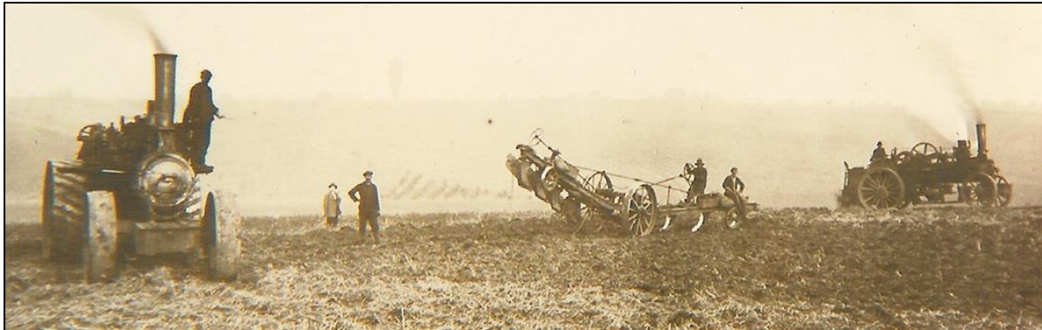
Eine Dampfpflugeinheit im Einsatz: der Kippflug wird wechselseitig gezogen, hier von rechts nach links
