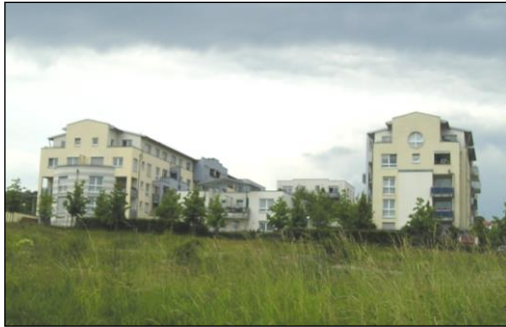
Der erste Bauabschnitt des Wohngebietes Schillerhöhe, Blick von Süden
