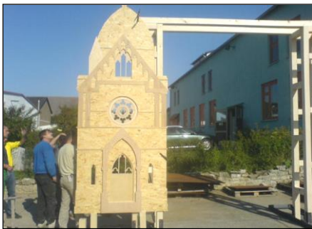
Der Bau des Herz-Jesu-Tores
