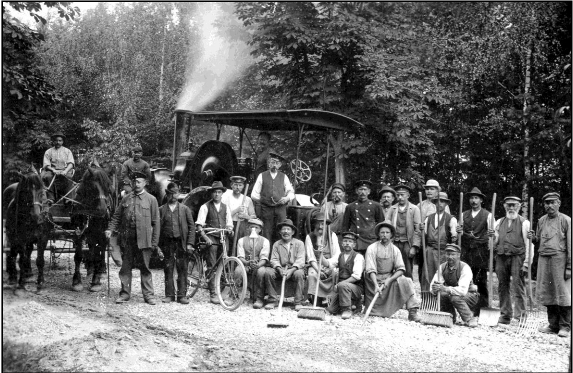
Arbeiten mit einer Dampfwalze in der Prinzenschneise. Wann das Foto gemacht wurde ist unbekannt.
