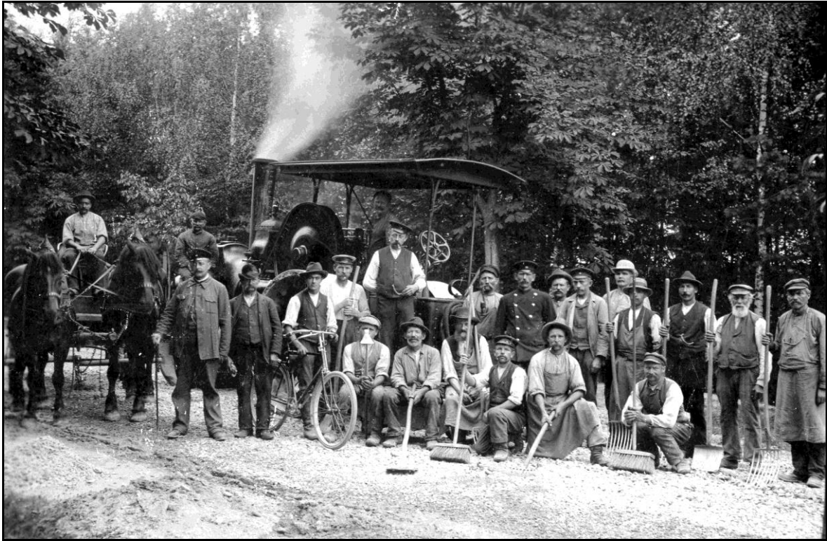
Arbeiten mit einer Dampfwalze in der Prinzenschneise. Wann das Foto gemacht wurde ist unbekannt.
