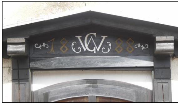
Das Türdetail mit dem Schriftzug 1888 und den Initialen GW (Graneß, Walter) nach der Sanierung im März 2008
