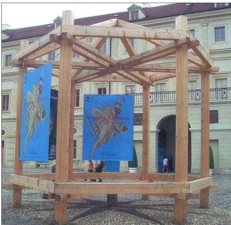
Das Holzgerüst im Schloßhof
