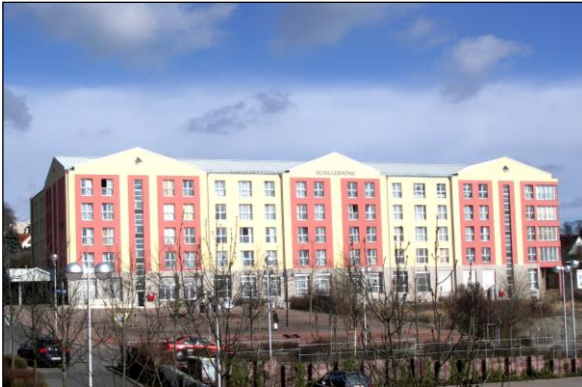
Die Ansicht von Süden
