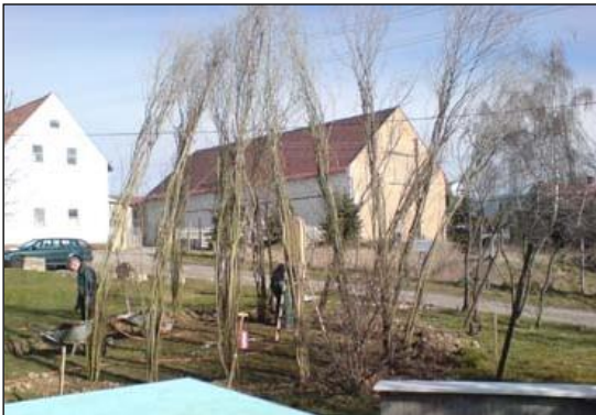
Der Bau des Weidenhauses
