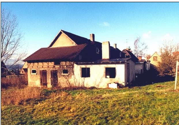
Ein verfallenes unbewohntes Gutsarbeiter-Wohnhaus um 2001
